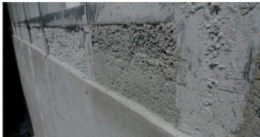
CONFORMACIÓN DE TABIQUES (tableros + h° alivianado)
