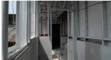
APLICACIÓN DE PANELES (silicato de calcio)
