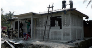
APLICACIÓN DE MASILLA (juntas y tornillos)
