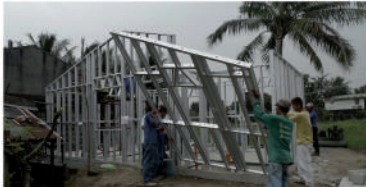
MONTAJE - ESTRUCTURA PORTANTE
