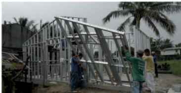
MONTAJE - ESTRUCTURA PORTANTE
