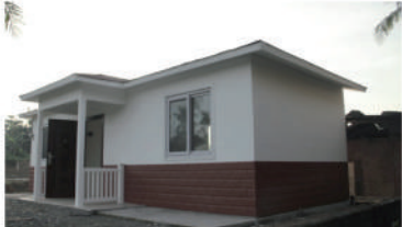
MODELO DE VIVIENDA ACABADA (exterior)
