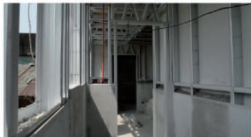
APLICACIÓN DE PANELES (silicato de calcio)
