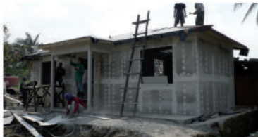
APLICACIÓN DE MASILLA (juntas y tornillos)
