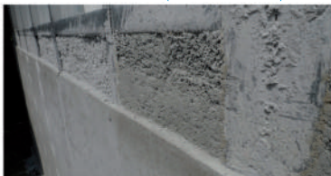
CONFORMACIÓN DE TABIQUES (tableros + h° alivianado)
