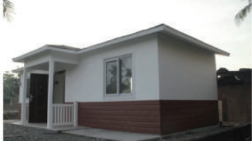
MODELO DE VIVIENDA ACABADA (exterior)
